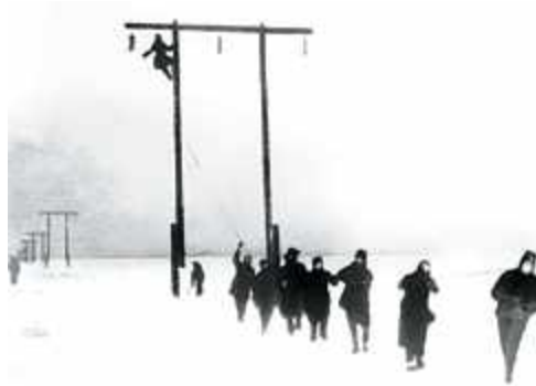
Рис. 3 Подвеска проводов при строительстве ледовой ЛЭП
