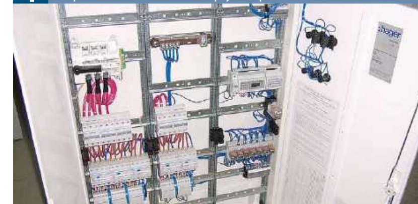
Рис. 3. Внутренний вид шкафов управления системой электрообогрева ТЕПЛОСКАТ на основе корпусов серий FW HAGER
