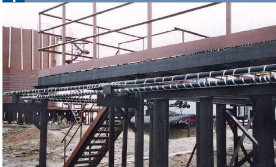
Рис.10. Система электрообогрева в стадии монтажа на месторождении
