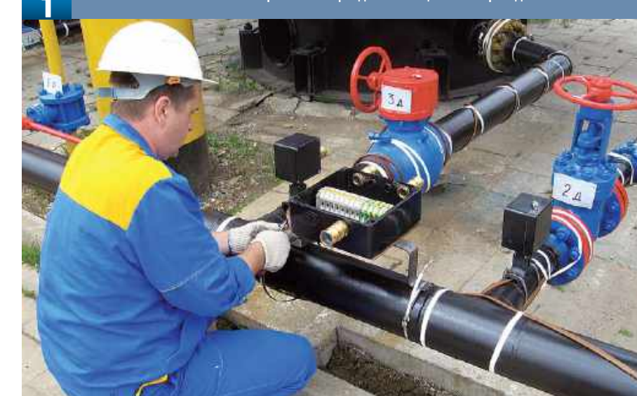
Рис.8. Монтаж системы обогрева на нефтедобывающем месторождении
