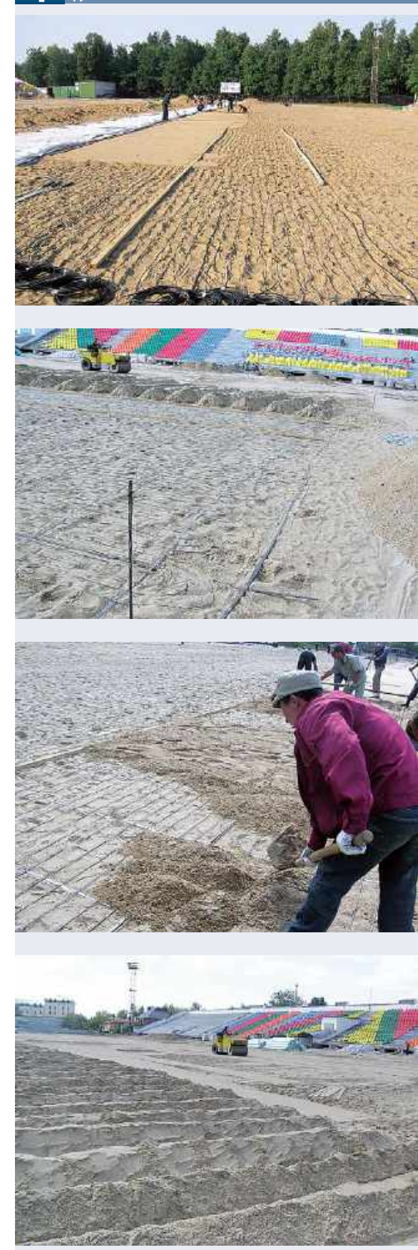
Рис.4. Монтаж устройства обогрева футбольного поля
