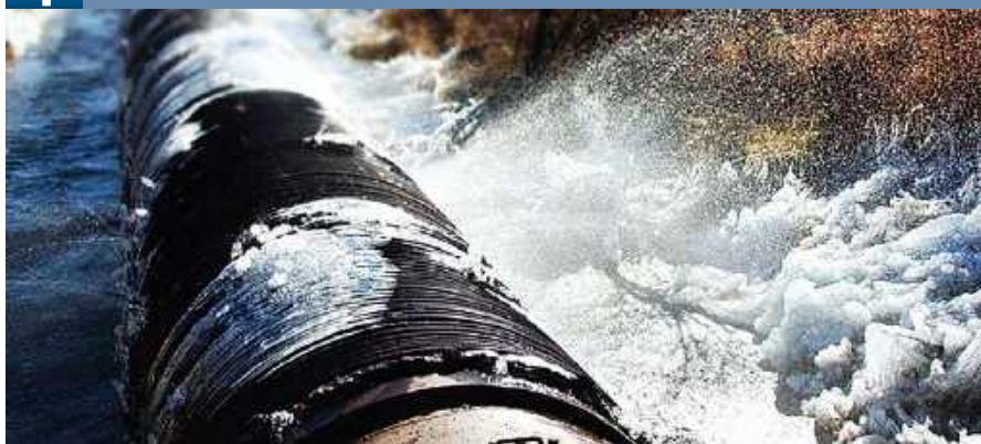
Рис.2. Замерзший водопровод
