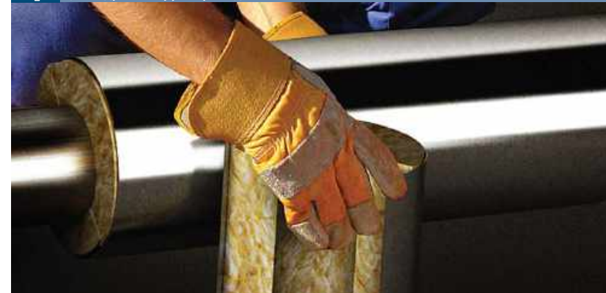
Рис. 3. Монтаж кашированных теплоизоляционных цилиндров на трубопроводе
