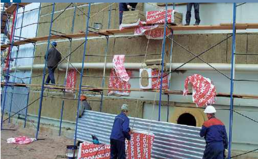
Рис.9. Система электрообогрева в стадии монтажа на месторождении
