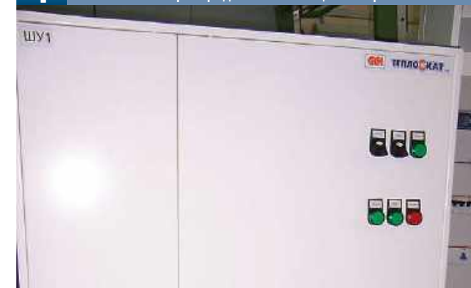
Рис. 2. Шкаф управления системой электрообогрева ТЕПЛОСКАТ на основе распределительных щитов серий FW HAGER
