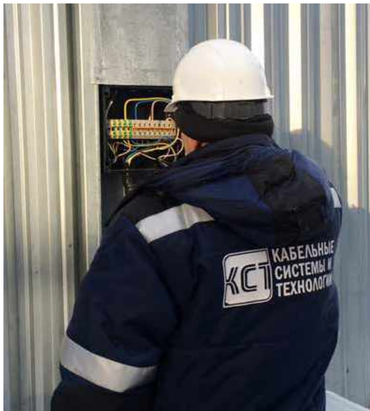
Монтаж шкафа управления.
