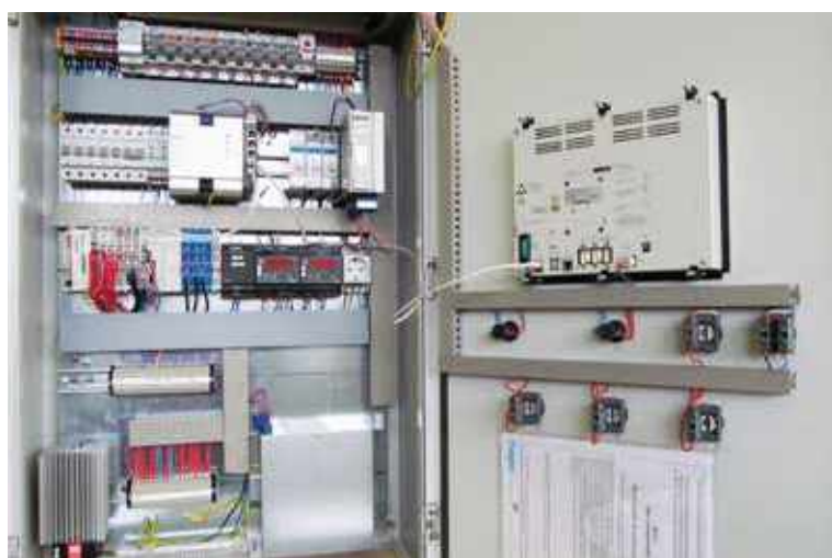
Рис. 16. Шкаф управления для систем промышленного электрообогрева ТЕПЛОМАГ.
