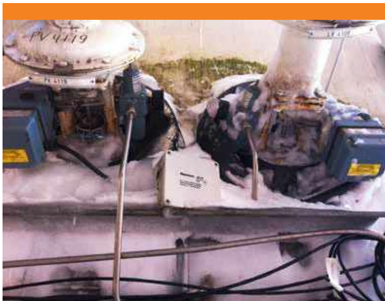
Рис. 1. Общий вид регулирующих клапанов, обмерзшего (справа) и обогреваемого (слева)
