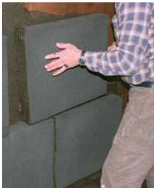
Рис. 9. Утепление стен блоками из пеностекла
