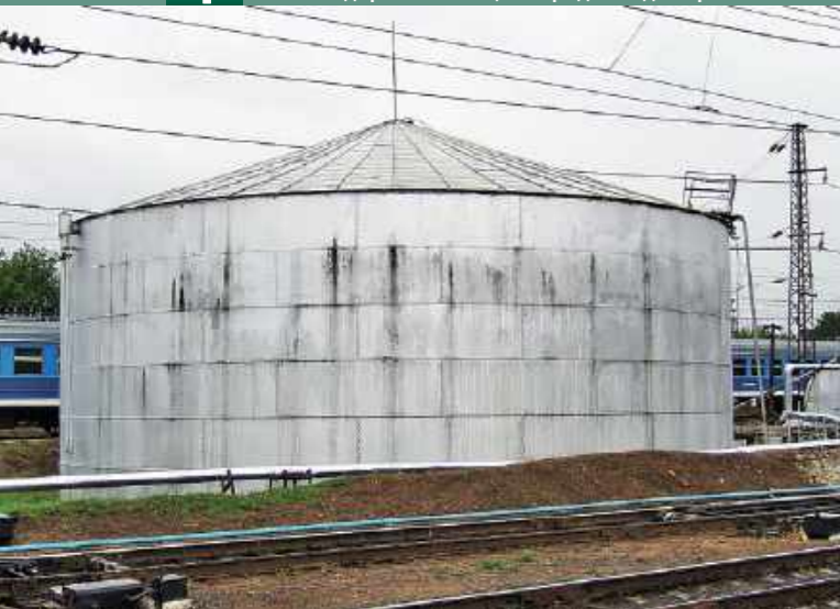
i Старинный клéпанный нефтяной резервуар Шухова на железнодорожной станции города Владимира
