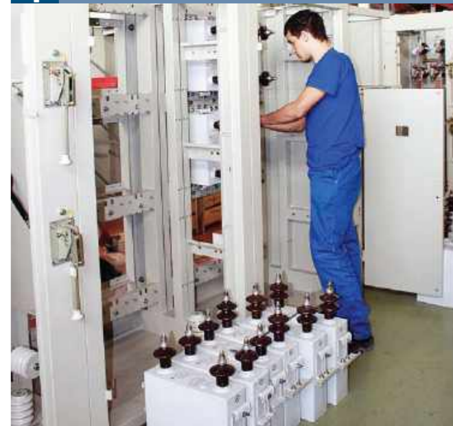
Рис. 2. Сборка шкафов управления
