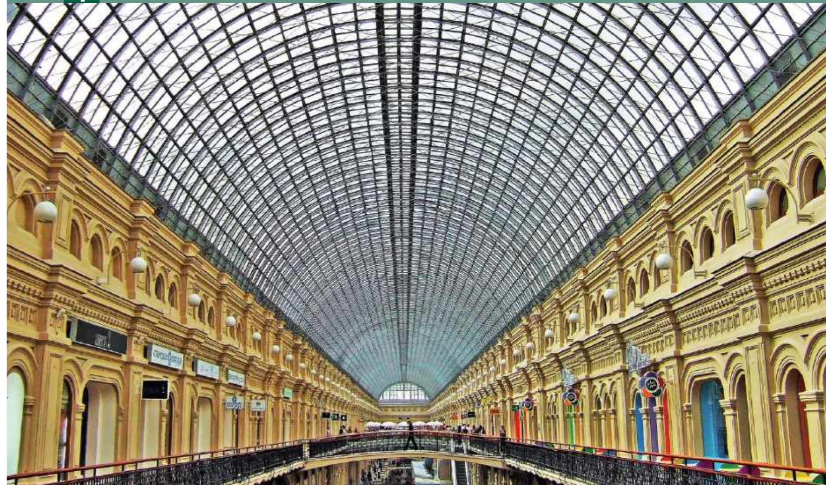
i Металло-стеклянные перекрытия ГУМа конструкции Шухова, Москва
