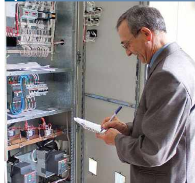
Рис. 1. Проверка ШУ системы обогрева с применением кабеля «Лонглайн»
