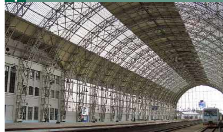
i Шуховский металло-стеклянный дебаркадер Киевского вокзала в Москве
